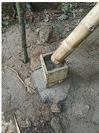
Figura 22. Fundición de pedestal con aprendices del técnico en construcción y mantenimiento en estructuras de guadua
