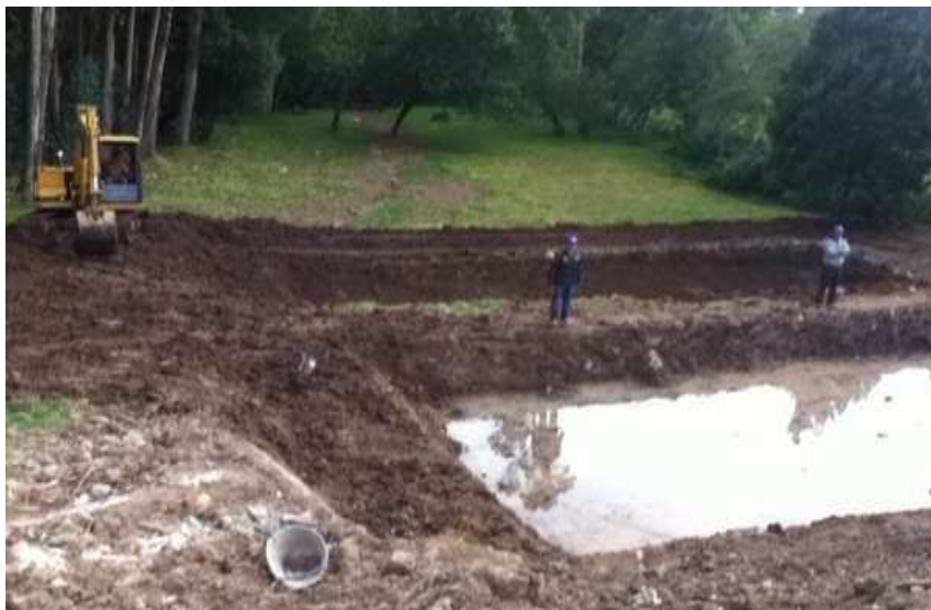
Figura 26. Descapote, excavación a máquina en material común y roca del humedal artificial
