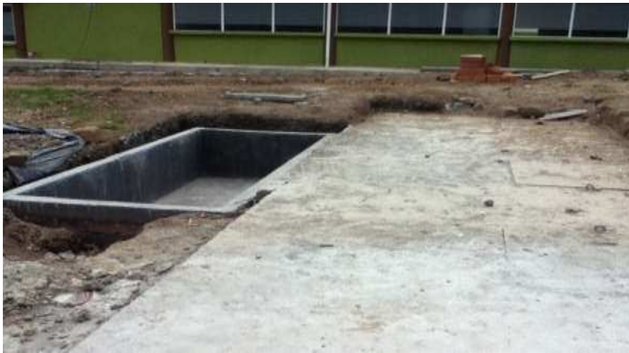
Figura 31. Losa de cubierta tanque séptico, filtro anaerobio y lecho de secado de lodos
