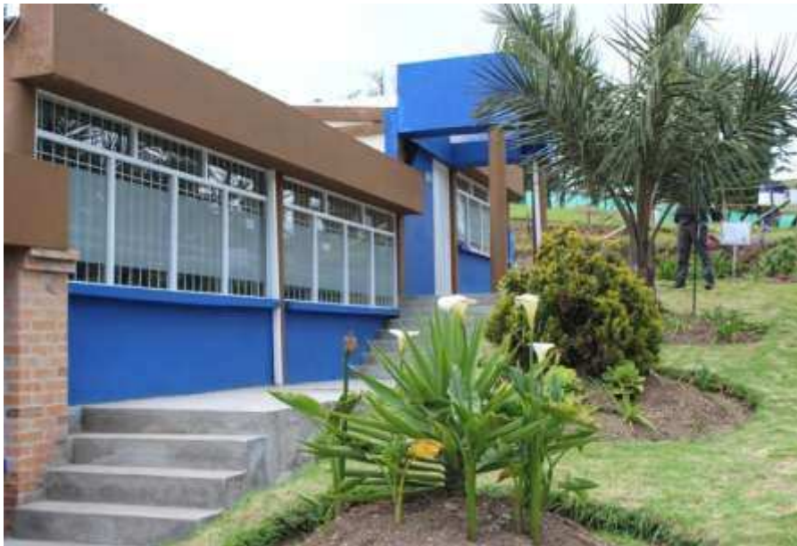
Figura 23. Instalaciones Colegio Comfamiliar Siglo XXI Sede Campestre
