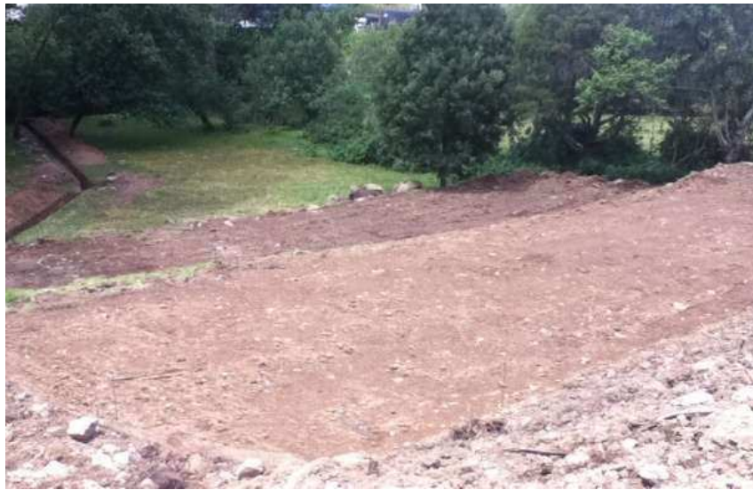
Figura 26. Descapote, excavación a máquina en material común y roca del humedal artificial
