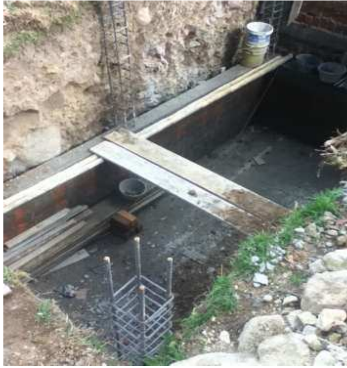
Figura 28. Sistema de drenaje de agua freática sobre el humedal artificial, previo a la estabilización de taludes y aplicación de solado
