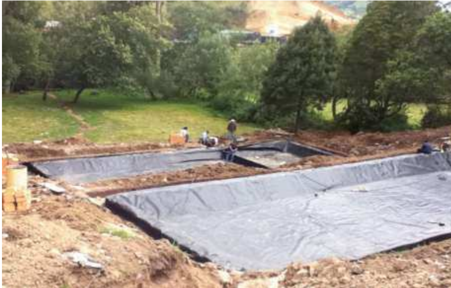
Figura 33. Instalación de la geomembrana
