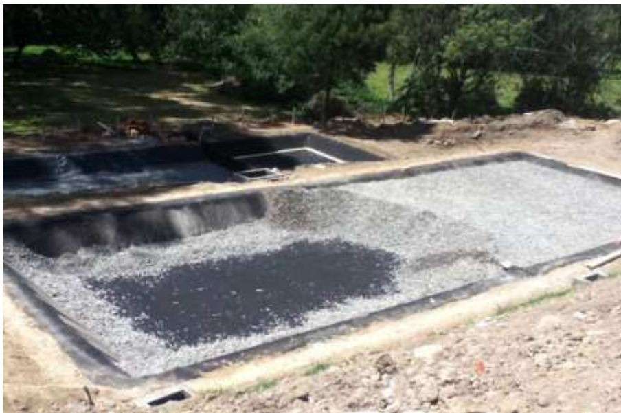
Figura 34. Instalación de lecho filtrante (grava de río de 25 mm)
