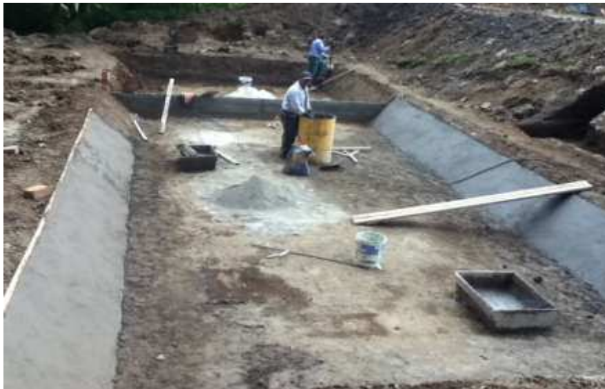
Figura 29. Aplicación de solado y estabilización de taludes con suelo – cemento
