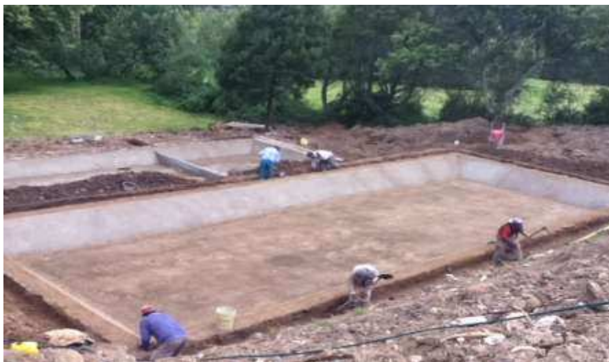
Figura 32. Construcción de zanja de anclaje de la geomembrana
