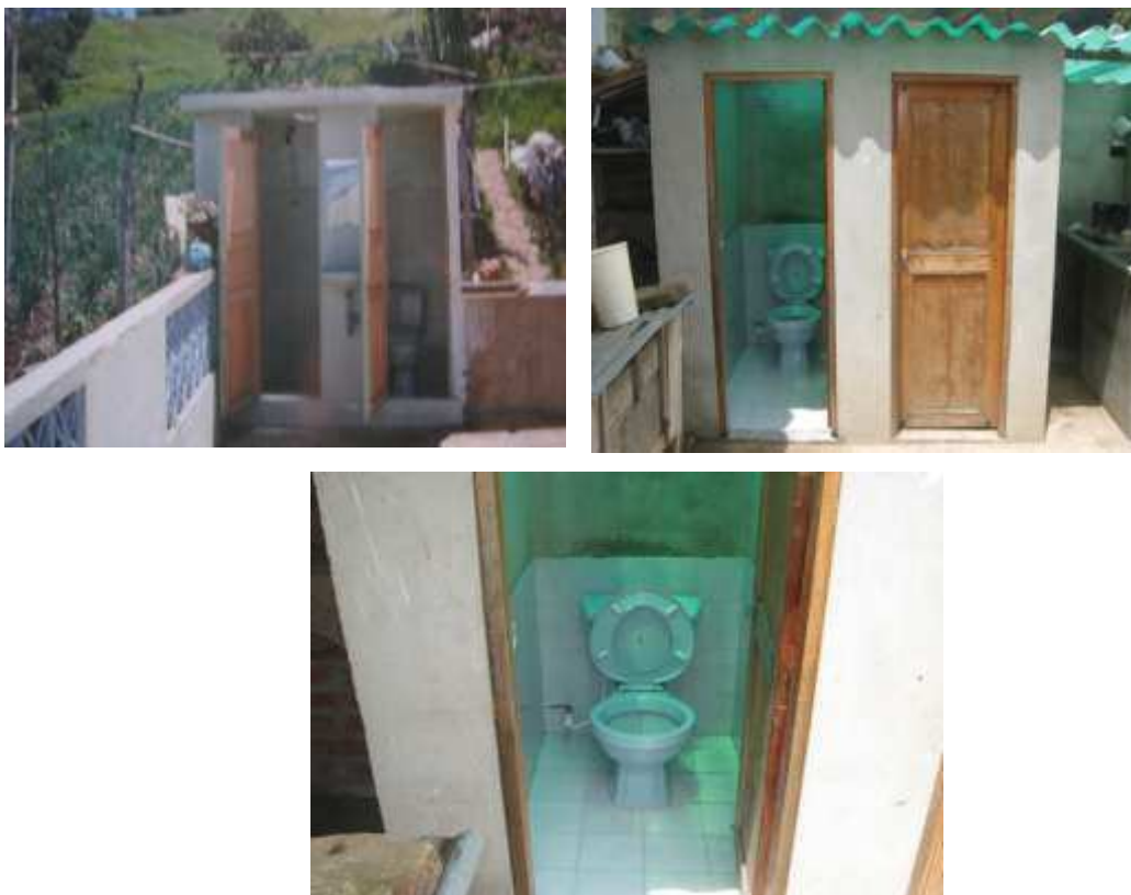
Figura 16. Batería sanitaria con condiciones adecuadas para su uso
