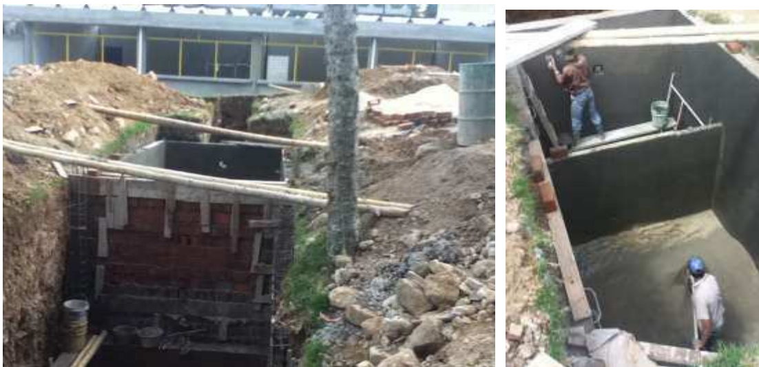
Figura 30. Mampostería y viga de corona Tanque séptico, filtro anaerobio
