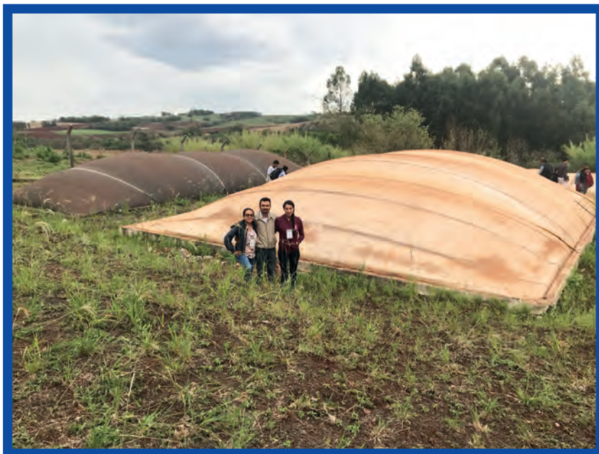
Almacenamiento Biog3s: Foz do Iguaz3 - Brasil
