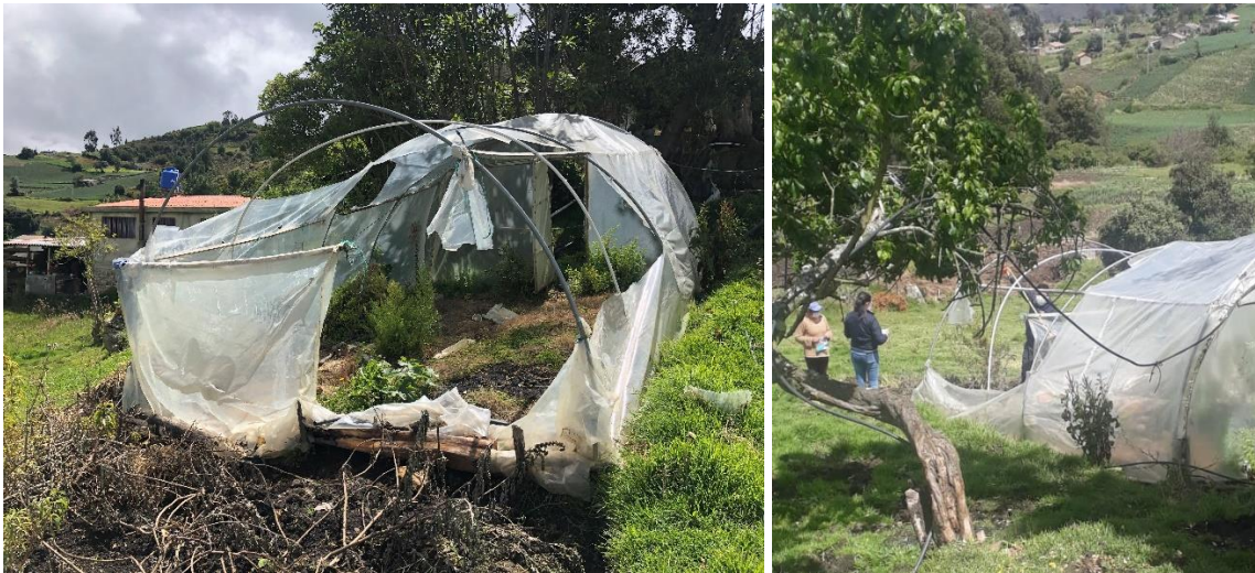
Fotografía 11. Estado actual del invernadero de propiedad de la beneficiaria Lucila del Carmen Bernal. Octubre 2020. Fuente: Equipo consultor.
