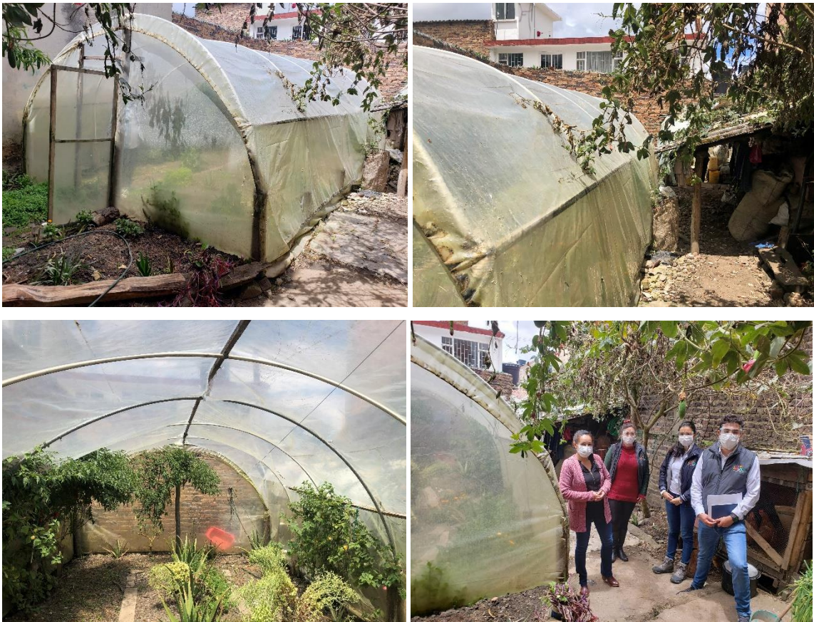
Fotografía 2. Estado actual del invernadero de propiedad de la beneficiaria Nubia del Carmen Alarcón. Octubre 2020. Fuente: Equipo consultor.
