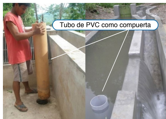
Figura 3. Utilización de tubo de PVC como compuerta Fuente: Archivos fotográficos de Soluciones Prácticas,
