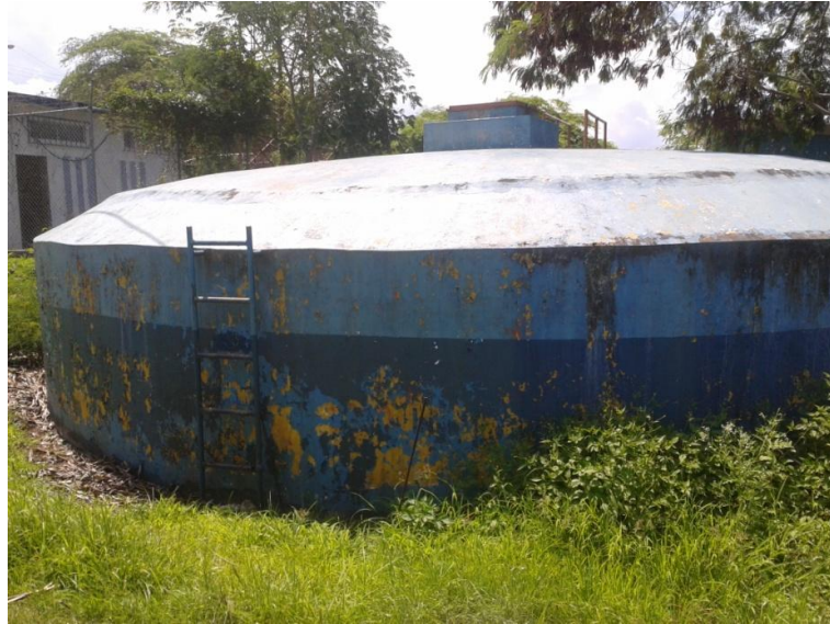
Figura 23.- Reservoirio 1: Reservoirio “circular” de 200 m 3 que abastece a las poblaciones de Montañita y Manglaralto
