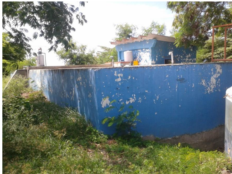
Figura 24.- Reservoirio 2: Reservoirio “Cuadrado” de 300 m 3 que abastece a las poblaciones de Rio Chico, Cadeate, San Antonio y Libertador Bolívar
