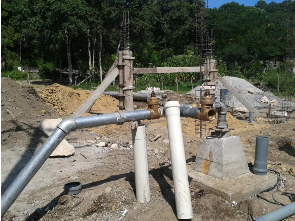
Figura 29.- Construcción del pozo 9 para uso exclusivo de Montañita y Nueva Montañita
