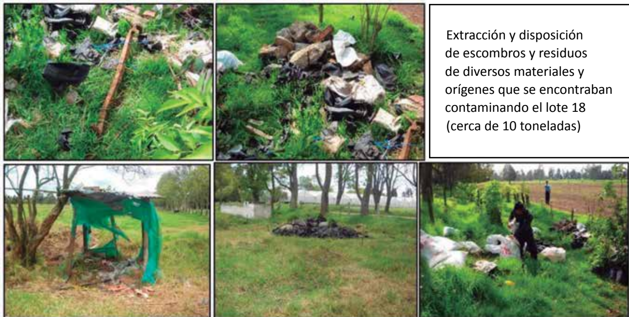
Figura 4. Lote 18. Limpieza del lote, previo al inicio de trabajos.
