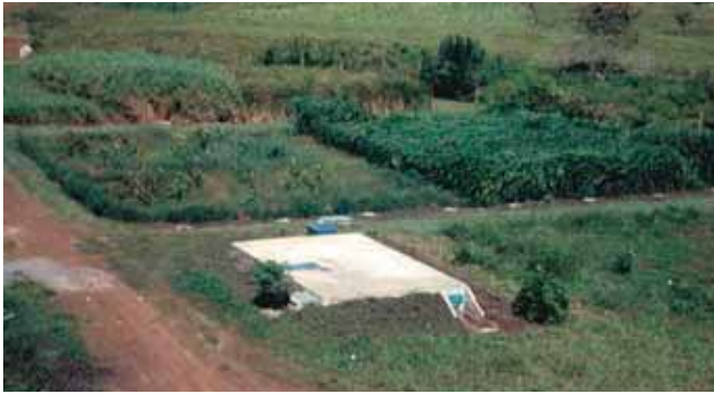
Vista panorámica del Biofiltro de Masaya en donde se muestran el tanque de sedimentación y las cuatro pilas del biofiltro.
