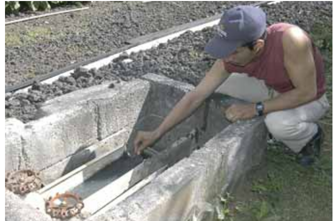
Operador midiendo el caudal de entrada a los Biofiltros
