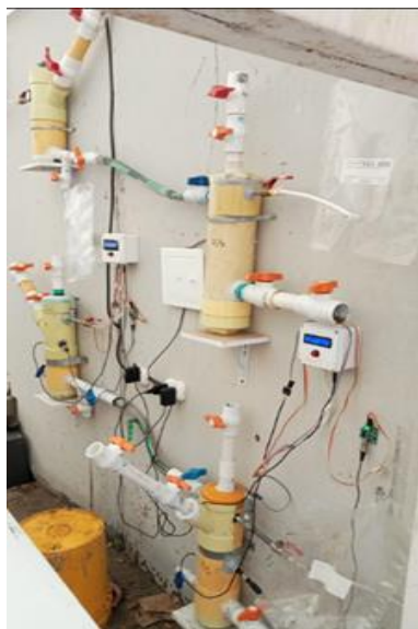
Fig. 31. Sistema de monitoreo ubicado en ambas etapas del reactor
