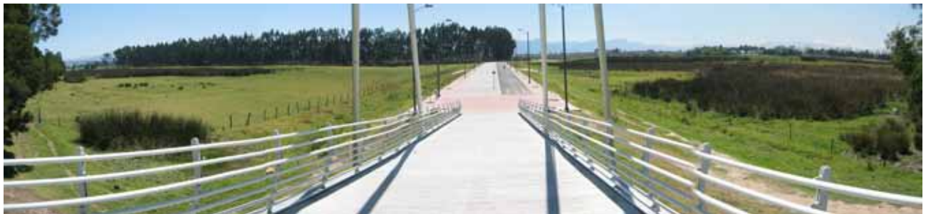
Fragmentación del hábitat para fauna en el Humedal Jaboque por la construcción de la cicloruta. Foto: F.G.Stiles & L. Roselli.
