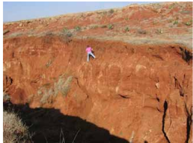
Figura 2. Talud lateral de la cárcava Capitán Caldera , microcuenca Monte Caldera.
