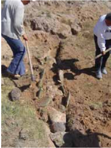
Figura 7. Zanja rellena con piedras y raquetas de nopal.
