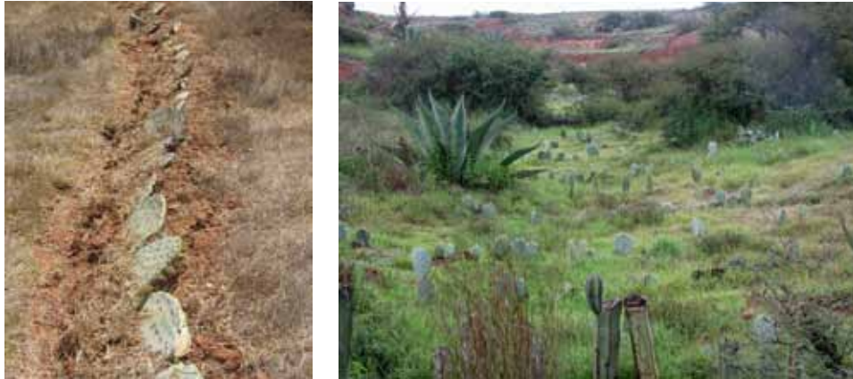
Figura 10. Detalle y distribución espacial de las barreras de nopal en el cauce principal de la cárcava. Una condición importante para garantizar la viabilidad de las raquetas de nopal, es evitar que el corte quede en contacto directo con el suelo. En la foto de la derecha se aprecia el desarrollo de la vegetación 8 meses después de establecer las estructuras biomecánicas.
