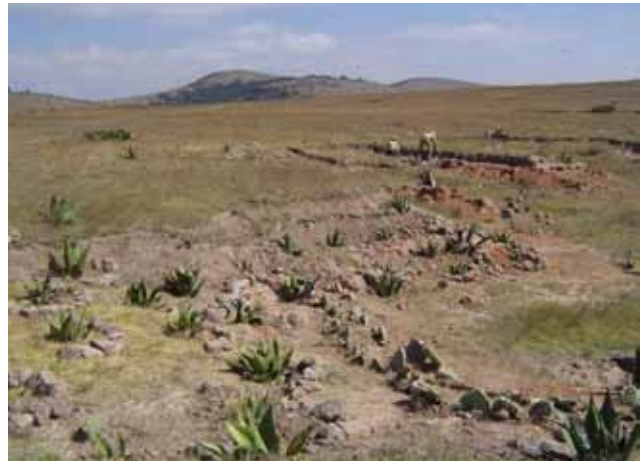
Figura 6. Perfilado y revestimiento vegetal del remonte superior.
