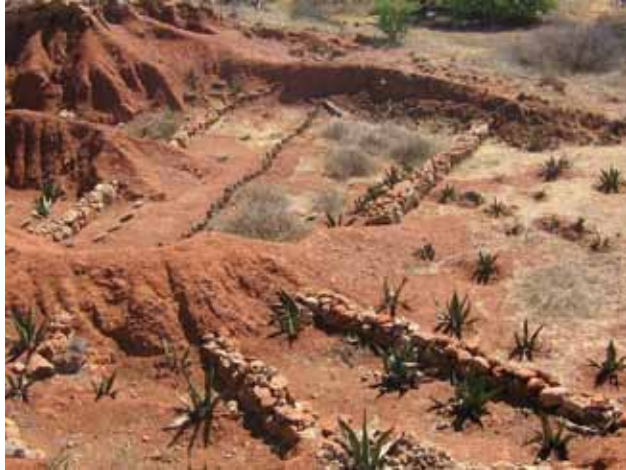
Figura 12. Establecimiento de obras y siembras para el manejo de un punto de confluencia de aguas dentro de la cárcava. Se conservaron las estructuras de piedra que habían sido construidas anteriormente. Octubre de 2008.
