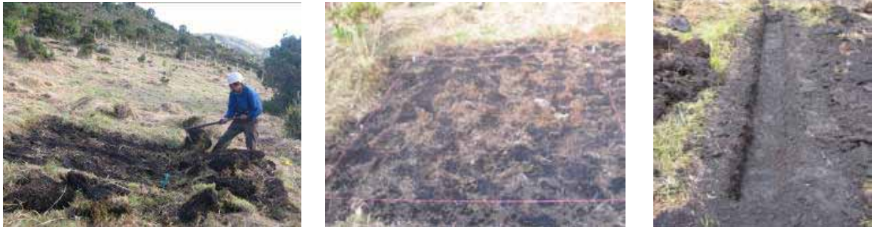
Figura 2. Creación de las parcelas de descompactación y trasplante de suelo.
