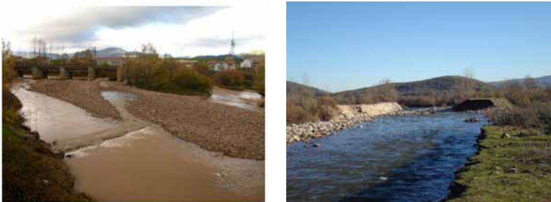
Figura 5. Barra de bolos cegando el cauce en Reinosa (izquierda), y dique lateral derruido por el poder erosivo del río (derecha).
