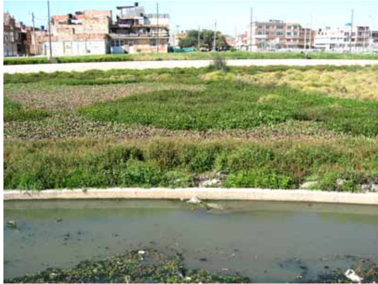
Construcción de canales perimetrales en el humedal de Jaboque modificaron su funcionamiento hidráulico.
