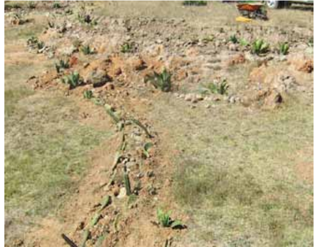
Figura 8. Barrera disipadora aprovechando recursos abundantes como piedras y nopal.
