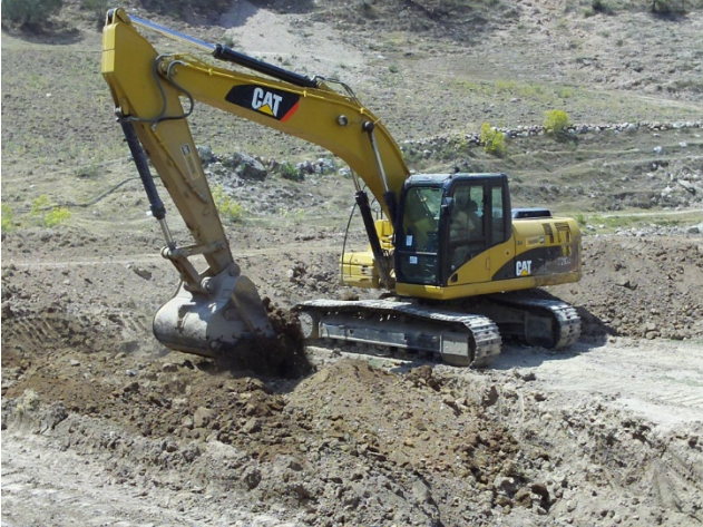
Figura 17. Máquina excavadora CAT 321DLCR en proceso de formación de la obra
