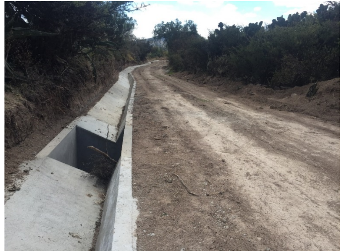
Figura 9. Desarenador en canal de llamada
