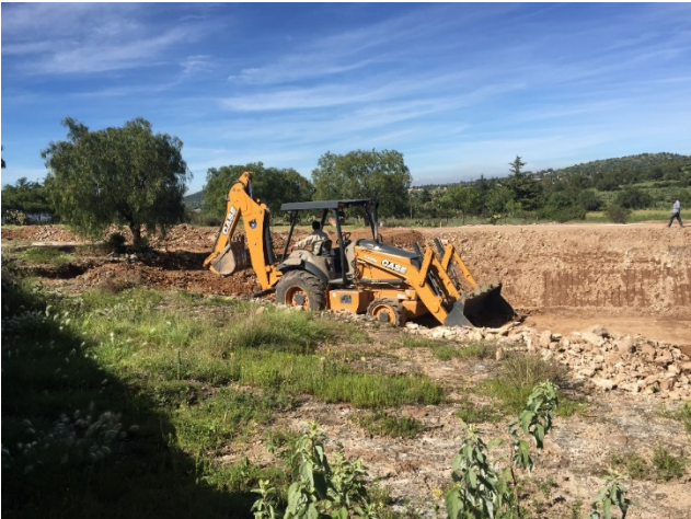
Figura 18. Máquina retroexcavadora CASE 580 en proceso de formación de un jagüey.
