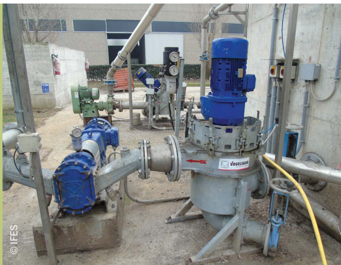
Imagen 21. Sistema de trituración en cámara de premezcla
