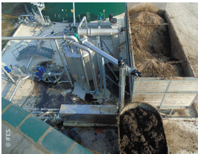
Imagen 23. Sistema de precarga de biodigestores con diferentes sustratos sólidos y líquidos
