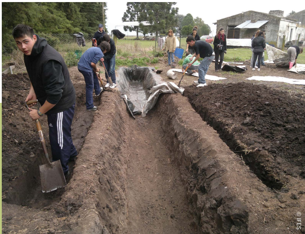
Imagen 31. Instalación de biodigestor tubular
