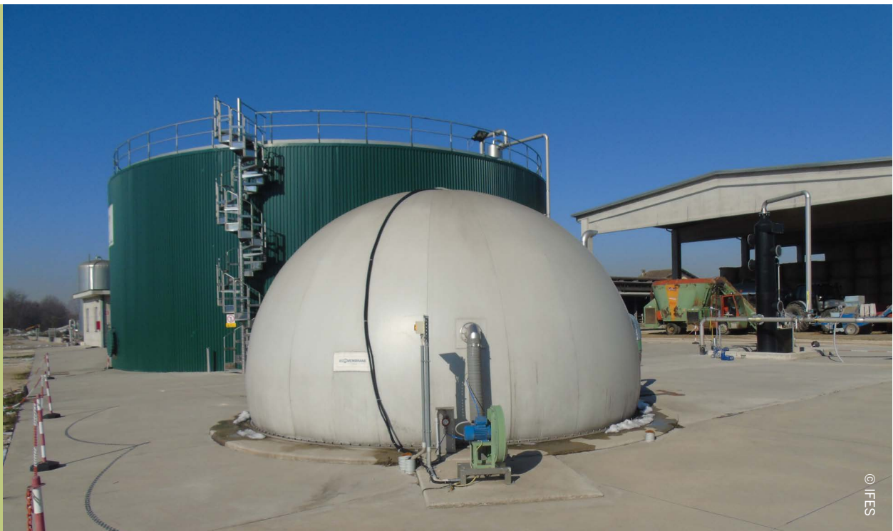
Imagen 5. Biodigestor mezcla completa de alta tecnología
