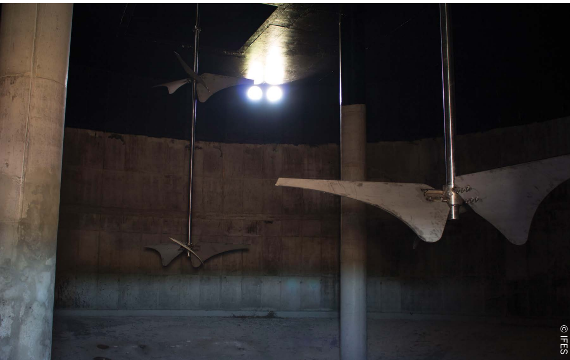
Imagen 26. Vista interna de agitadores verticales de acero inoxidable
