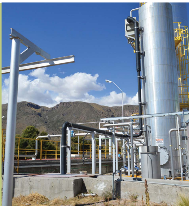
Imagen 6. Reactor UASB
