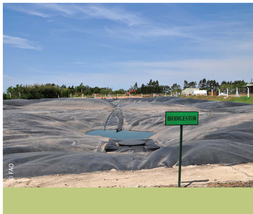
Imagen 4. Biodigestor laguna anaeróbica de media-baja tecnología
