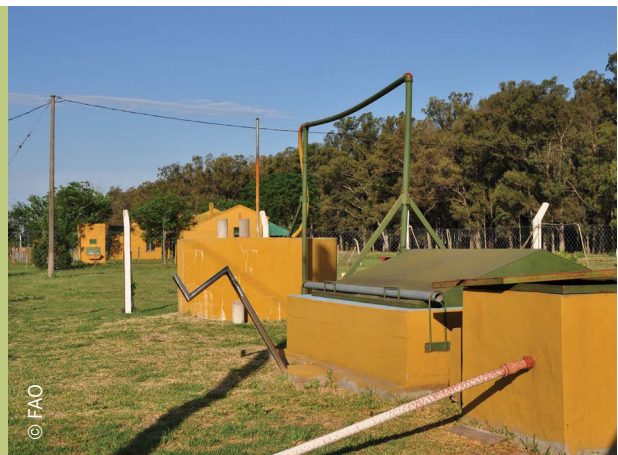
Imagen 3. Biodigestor tipo chino
