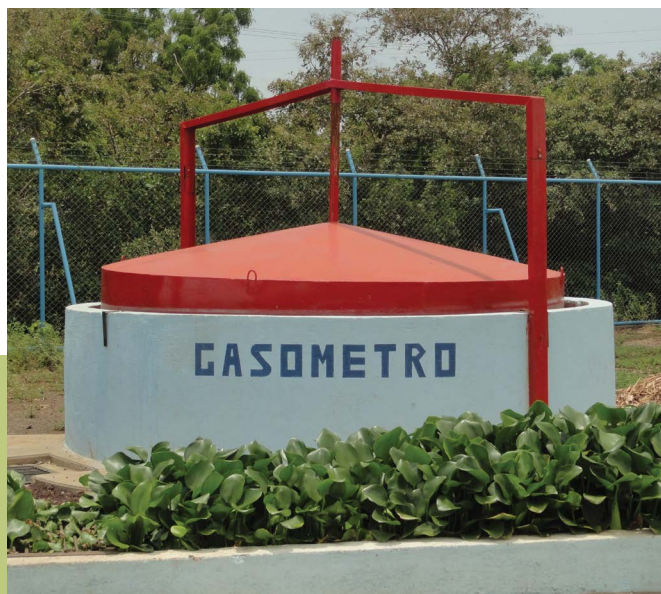
Imagen 9. Diferentes tipos de gasómetros flotantes
