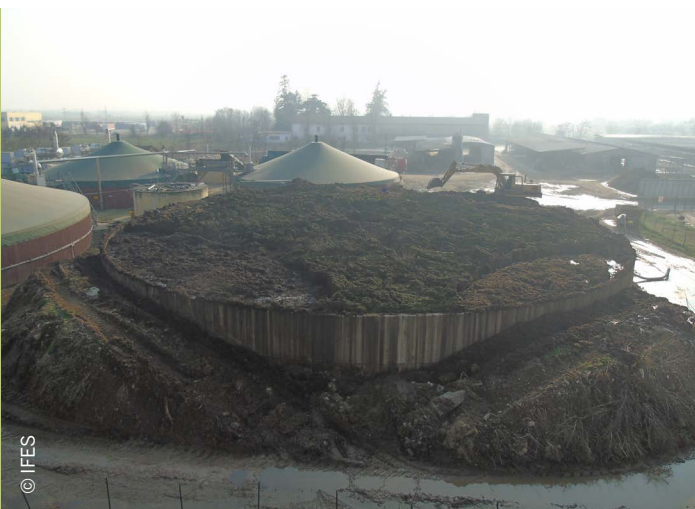
Imagen 14. Exceso de costra superficial en reservorio de digerido en central de biogás
