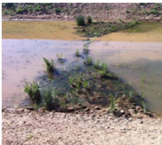
Deflectores de macrófitos con rollos y herbazales estructurados en fibra
