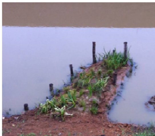
Deflectores de macrófitos con rollos y herbazales estructurados en fibra
