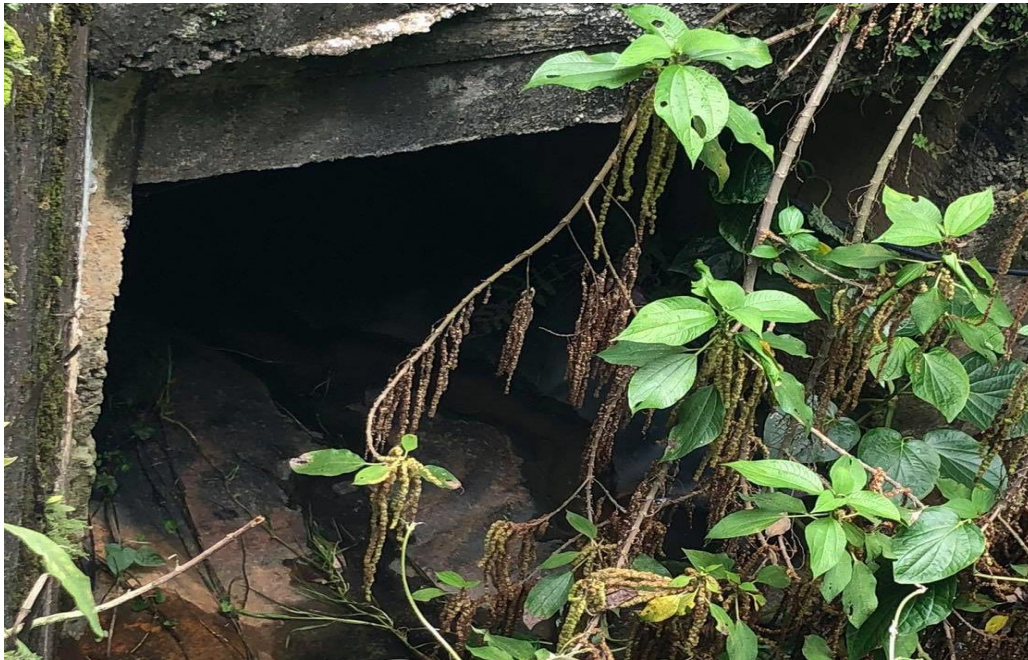
Fig. 28. Obra hidráulica tipo “box culvert” ubicada en la variante de palmas.
