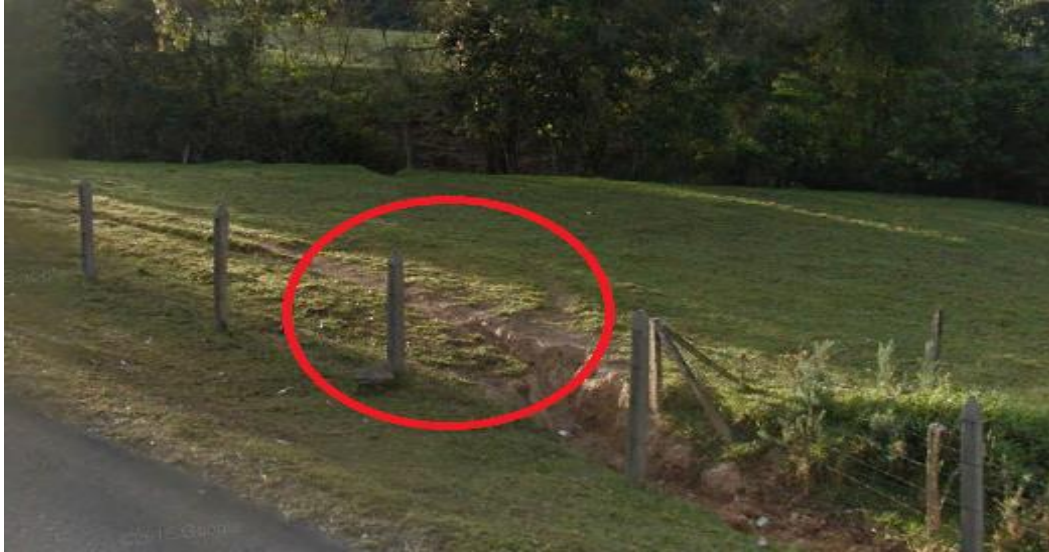
Fig. 29. Sistema de cercado actual en la vía variante de palmas
