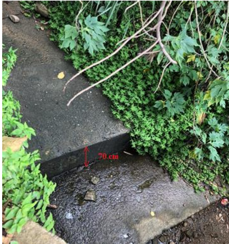
Fig. 33. Escala adyacente a una de las obras hidráulicas construidas en cemento.
