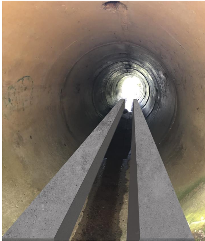
Fig. 32. Boceto de implementación de plataforma convencional que permite la realización de un cruce de manera seca para la fauna.
