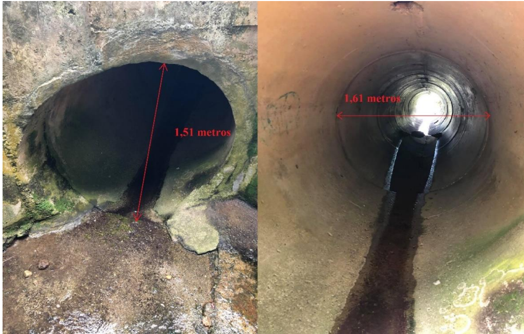
Fig. 27. Obra hidráulica tipo drenaje ubicada en la vía variante de palmas.
