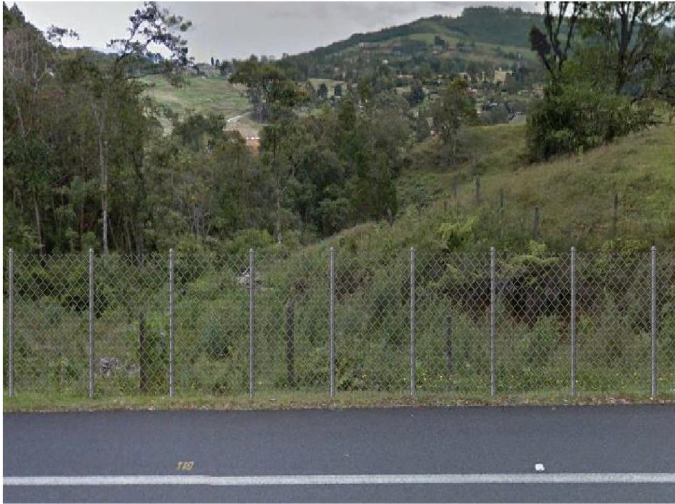
Fig. 35. bosquejo de la implementación de la malla eslabonada en los extremos de la vía variante de palmas.
