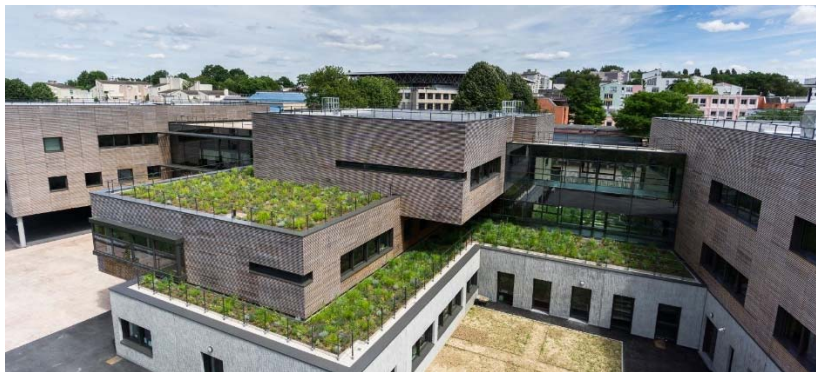
Fig. 10: Ejemplo de techo verde en ciudades. Fuente: Recuperado de https://zincogreenroof.com/systems/irrigated-extensive-green-roof
