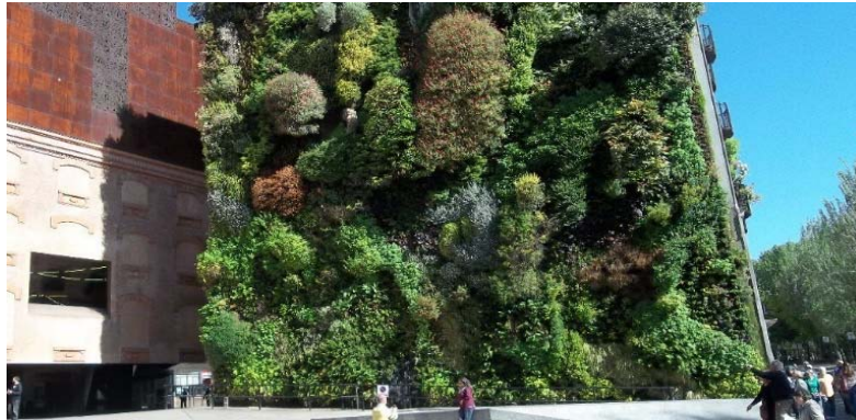
Fig. 11: Muro verde en el Paseo del Prado (Madrid). Fuente: Recuperado de https://www.miradormadrid.com/paseo-del-prado/paseo-del-prado-24/
